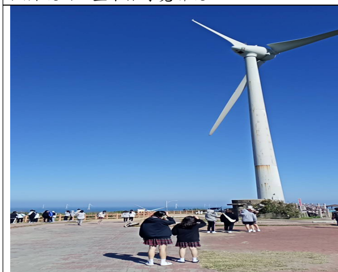
拍照日期：112.11.28 照片說明：再生能源-風力發電設施參訪1
